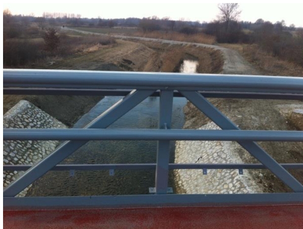
Slika 30. Novoizgrađeni most za pješake i bicikliste na rijeci Plitvici, 30.1.2016. [2]
