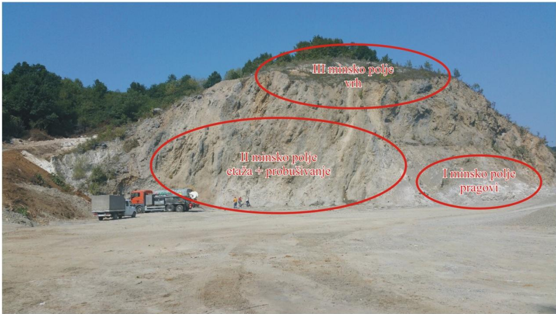
Slika 20. Jugoistočni dio kamenoloma prije prvog proizvodnog miniranja
