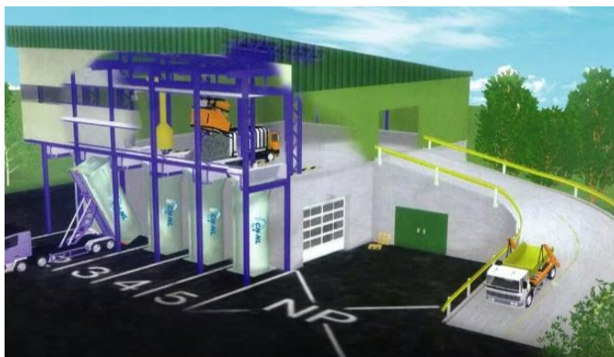
Slika 28. Vertikalni način izvedbe pretovarne stanice [35]
