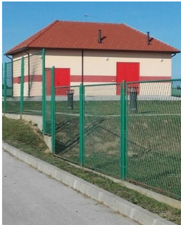
Slika 22. Precrpna stanica Kućan [2]
