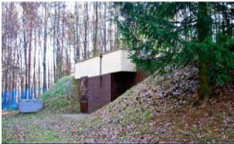
Slika 21 : Vodosprema Lužan volumena 400 m 3 [11]
