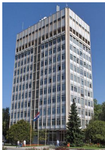
Slika 8. Zgrada vodotornja u Varaždinu [14]
