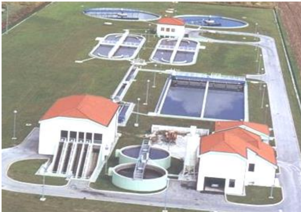
Slika 1. Uređaj za pročišćavanje otpadnih voda u Čakovcu
