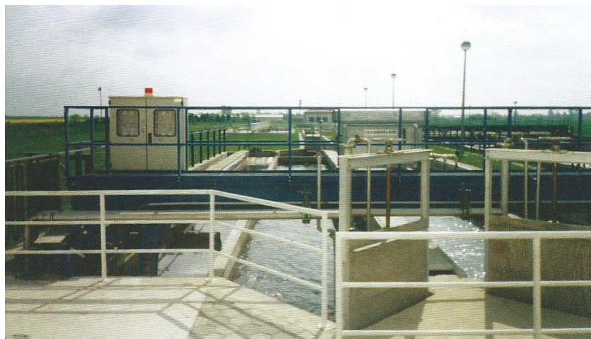
Slika 8. Prozračeni pjeskolov – mastolov na uređaju u Čakovcu
