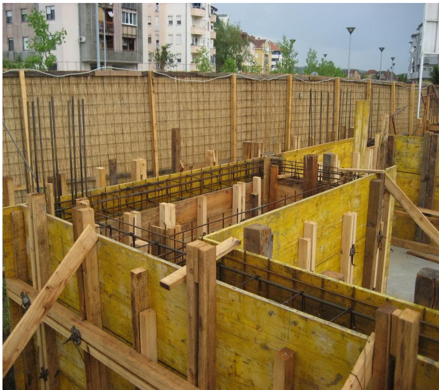
Slika 7. Postavljanje oplata za betoniranje zidova [5]
