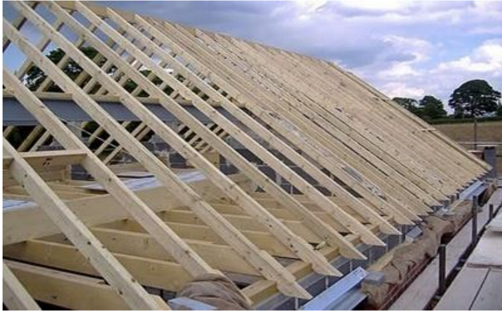
Slika 6. Postavljanje krovišta [5]
