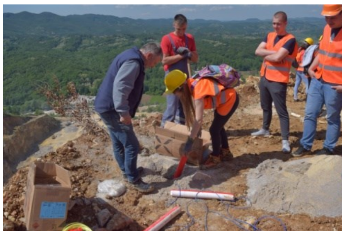
Slika 4.16. Punjenje minske bušotine eksplozivom.
