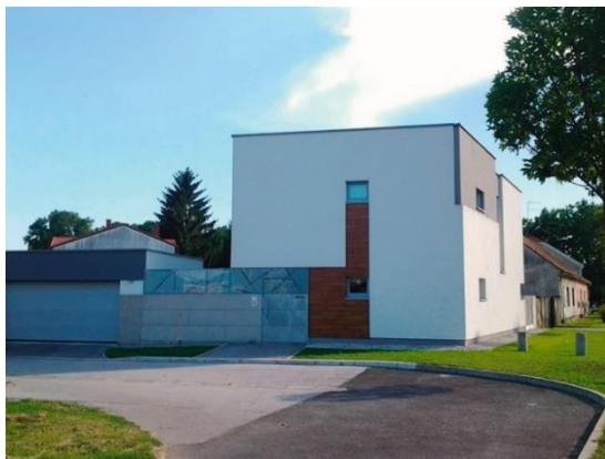
Slika 1. Pasivna kuća u Varaždinu, Ulica Ante Starčevića,18
