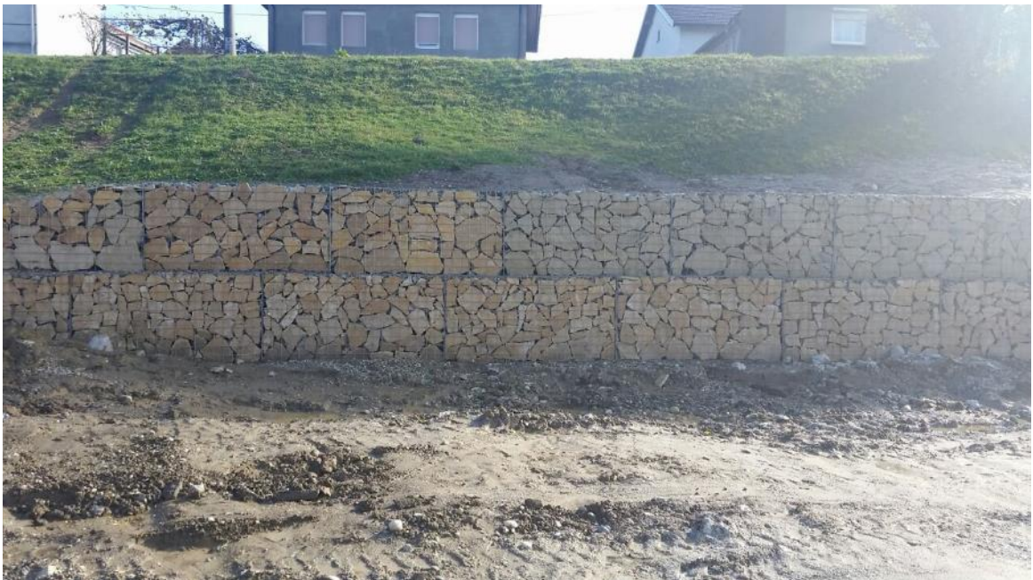
Slika 21. Sanacija klizišta, Šenkovec (preuzeto s: http://www.monterra.hr/en/projekti/ )
