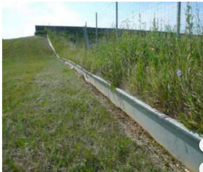
Slika 19. Kombinirana ograda za zaštitu divljači i vodozemaca (LACON, 2014).
