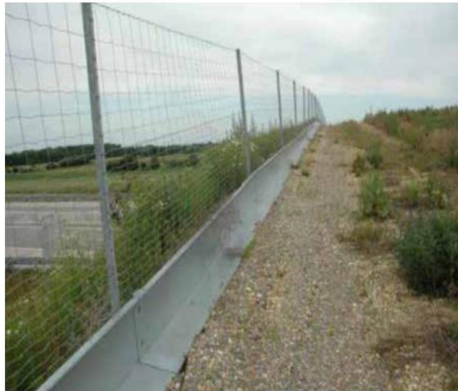
Slika 18. Kombinirana ograda za zaštitu divljači i vodozemaca (LACON, 2014).
