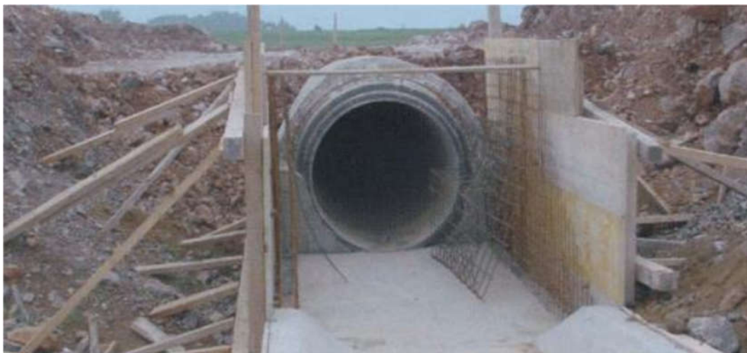
Slika 9. Poprečni presjek cijevnog propusta [3]
