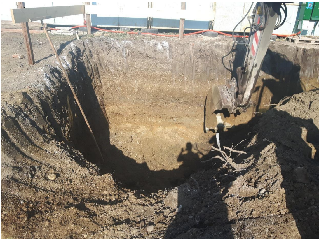
Slika 3. Strojni iskop jame
