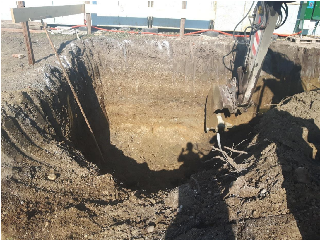
Slika 3. Strojni iskop jame
