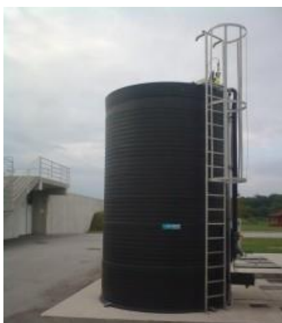
Slika 8. Tank za obradu fosfora [11]
