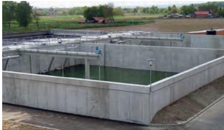
Slika 9. SB – reaktori na uređaju u Koprivnici [11]
