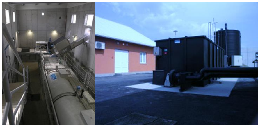
Slika 7. Biofiltrar za pročišćavanje zraka [11]
