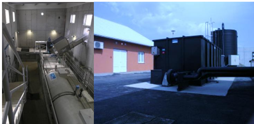
Slika 7. Biofiltrar za pročišćavanje zraka [11]
