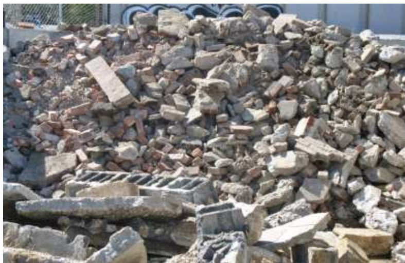
Slika 1. Šuta nastala tijekom rušenja [3]
