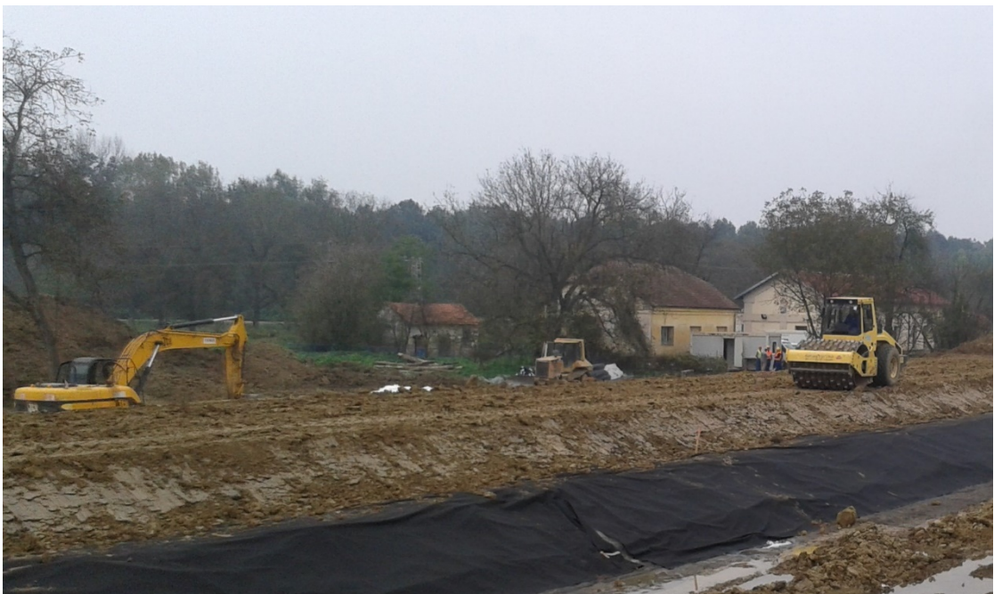
Slika 21. Zbijanje tla ježom pri gradnji nasipa
