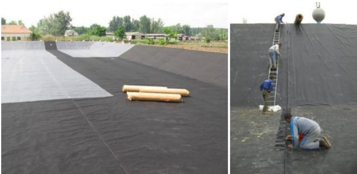
Slika 8. Ugradnja geomembrane [8]
