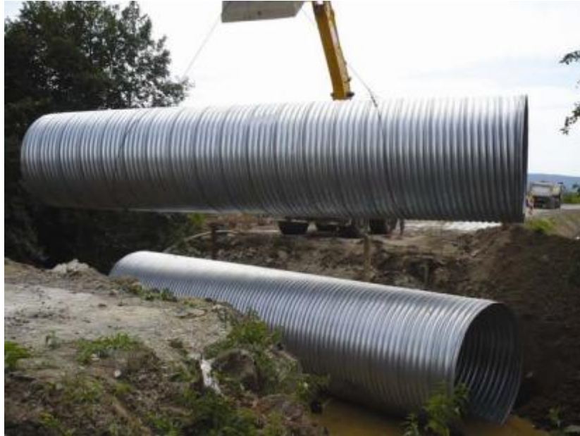
Slika 14. Cijevni propusti (Bogdan, 2009)
