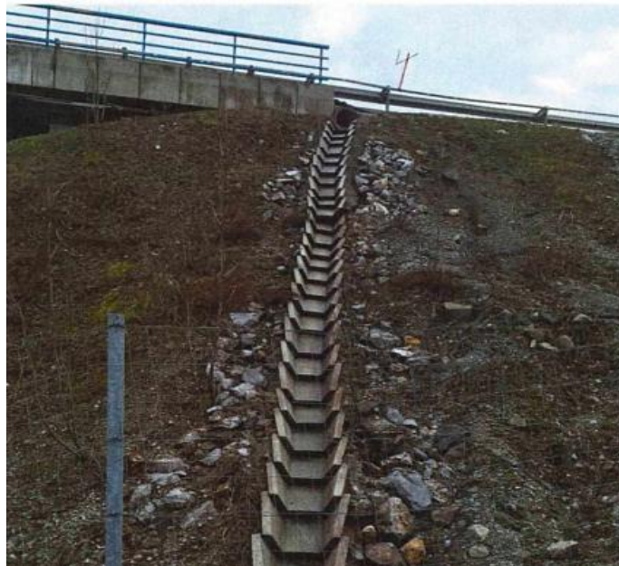
Slika 8. Otvoreni kanali niz pokos do prihvatnog kanala (HAC, 2018)
