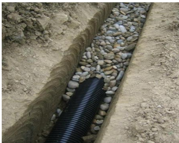
Slika 9. Drenažni sustav ( https://www.emajstor.hr/clanak/23/Drenaza_izvedba_cijena )
