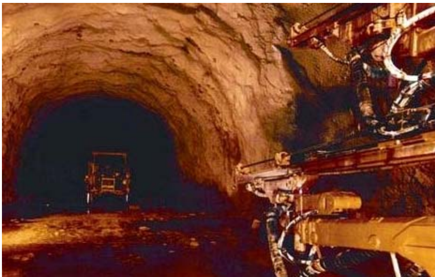
Slika 9.4 Iskop tunela Sveti Rok [12]
