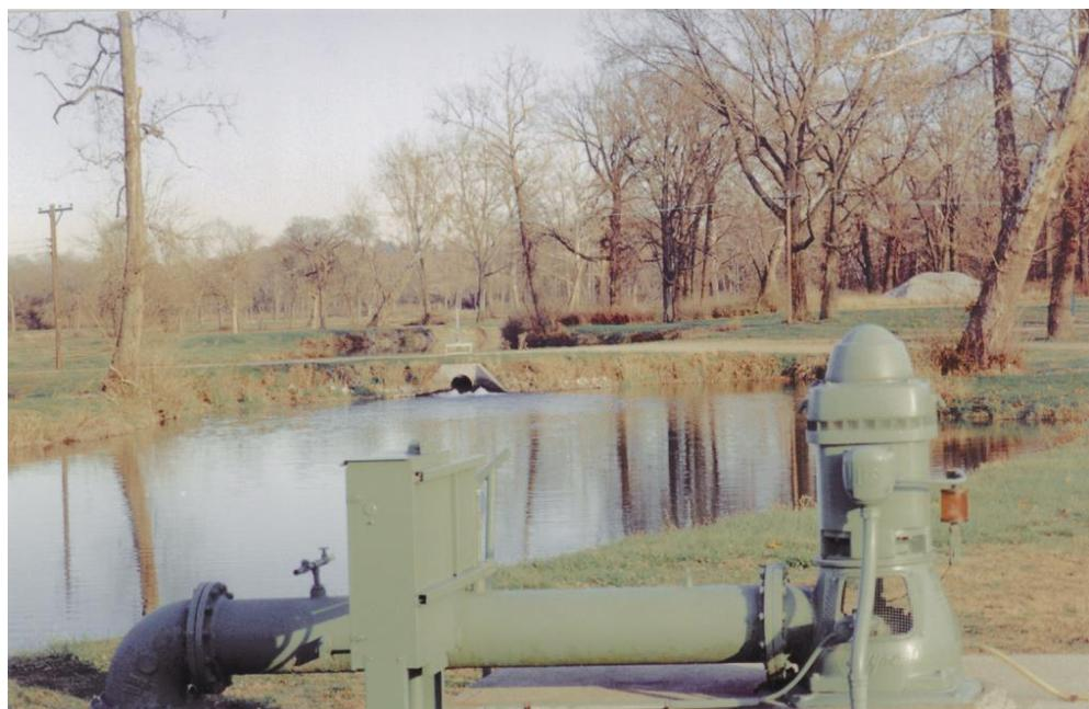
Slika 11. Turbinska pumpa velike snage instalirana na gradskoj bušotini na otoku Rohrers. (laguna prihranjivanja u pozadini) (Alley, M. et al., 1999)
