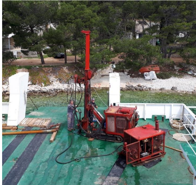
Slika 36. Istražno bušenje [22]
