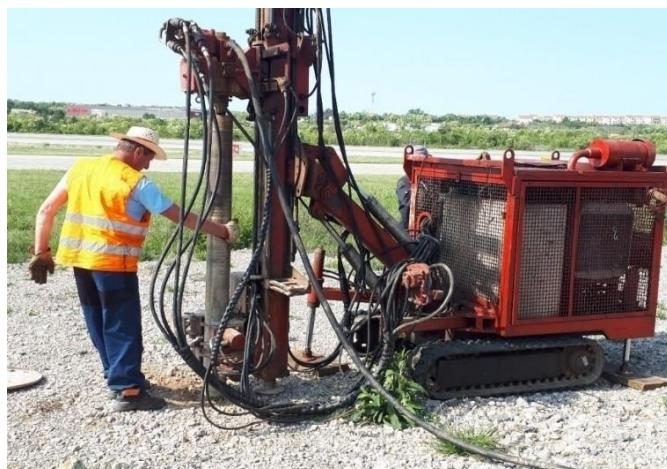
**Slika 18. Istražno udarno bušenje [27]**
