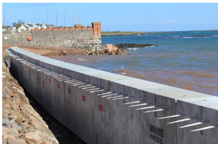
Slika 16. Morski zid kao zaštita od djelovanje valova [38]
