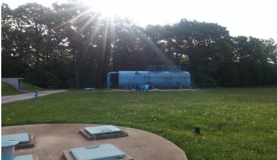
Slika 8. Sabirna komora spojena na filter s aktivnim ugljenom
