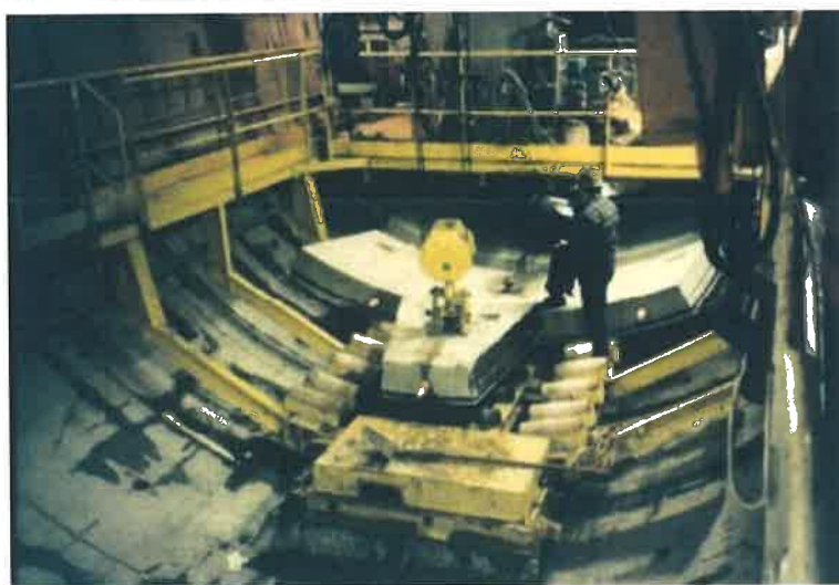
Slika 8.5. Postavljanje stroja u početno okno na gradilištu u Milanu; prikaz stražnjeg dijela stroja s podizačem kojim se segmenti postavljaju u prstenove segmentne obloge[21].
