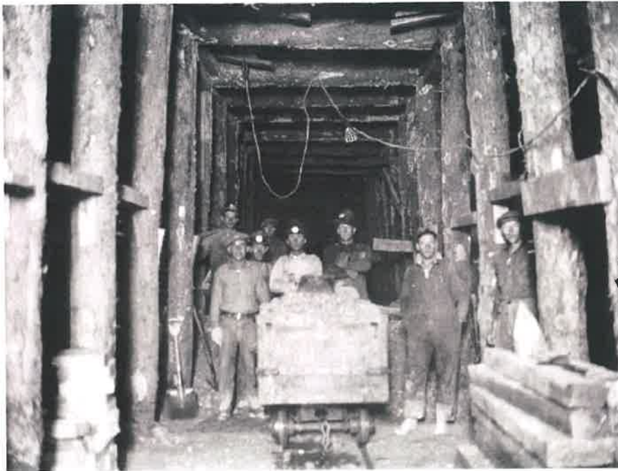
Slika 5.2. Teška drvena podgrada u tunelu Moffat, 1923. (USA) [5].
