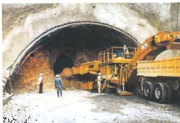
Slika 7.2. Stroj sa pokretnom glavom [5].
