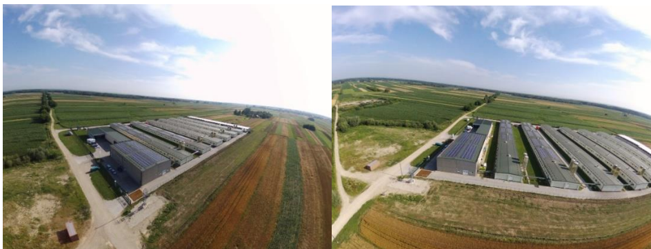
Slika 10. Sunčana elektrana Luneta u Svetom Đurđu (Solektra d.o.o.)
