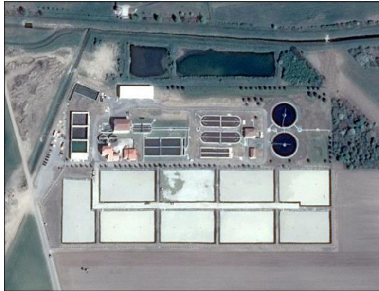
Slika 2. Uređaj za pročišćavanje otpadnih voda Čakovec [5]
