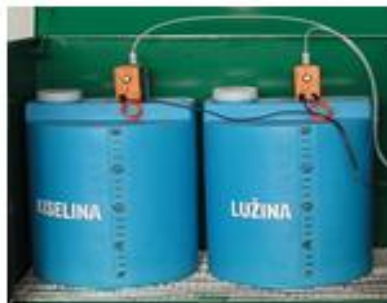
Slika 17. Uređaj za neutralizaciju [3]
