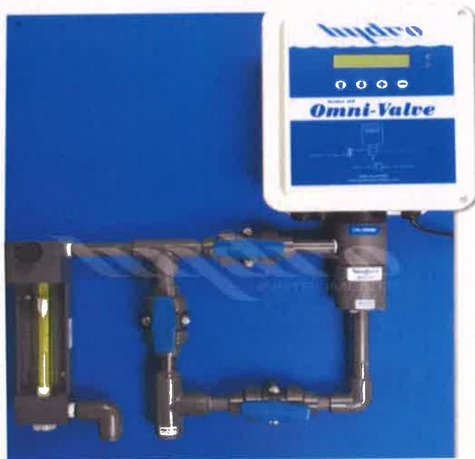
**Slika 23. Primjer automatiziranog sustava kloriranja podzemne vode**
