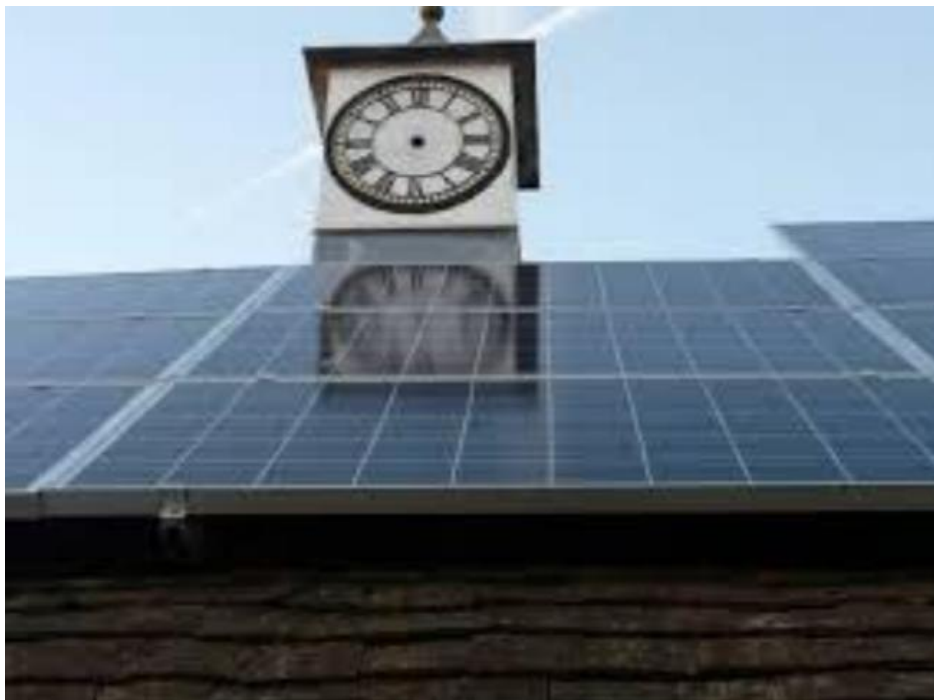
Slika 3. Zasjenjivanje fotonaponskih modula [1]
