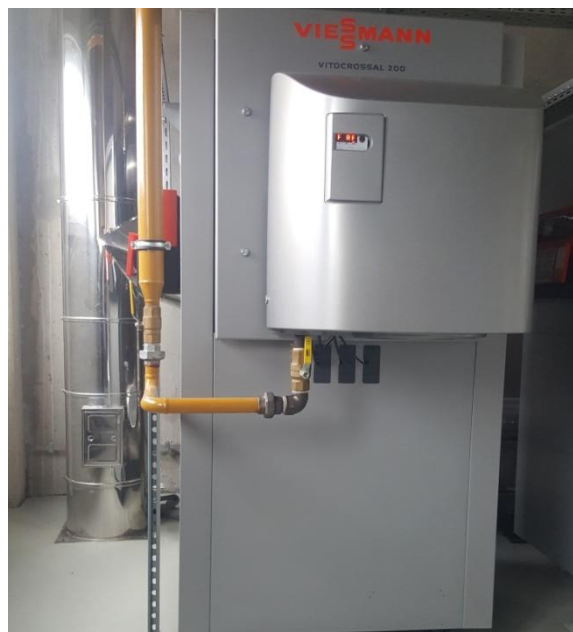
Slika 3. Plinski kondenzacijski kotao marke Vitocrossal 200
