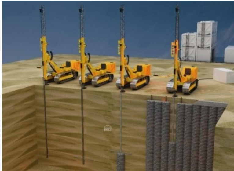
Slika 12. Mlazno injektiranje tla
