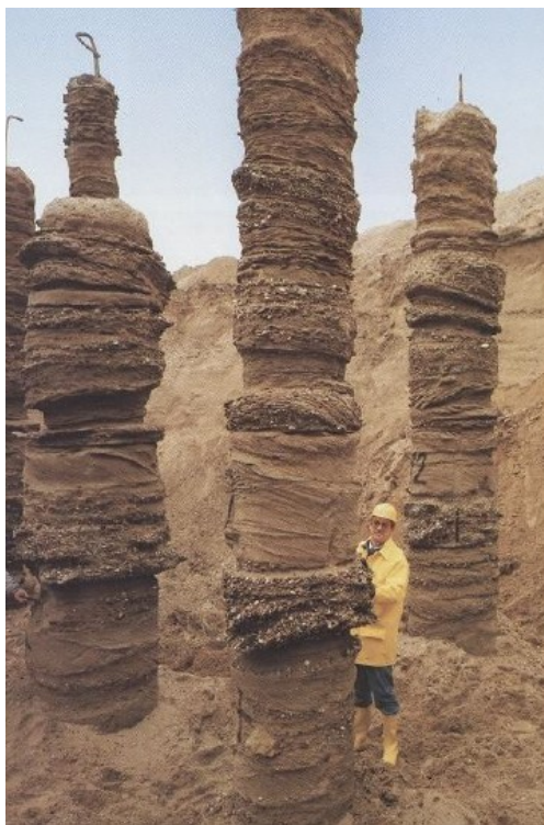
Slika 11. Stupnjaci nastali postupkom mlaznog injektiranja [6]
