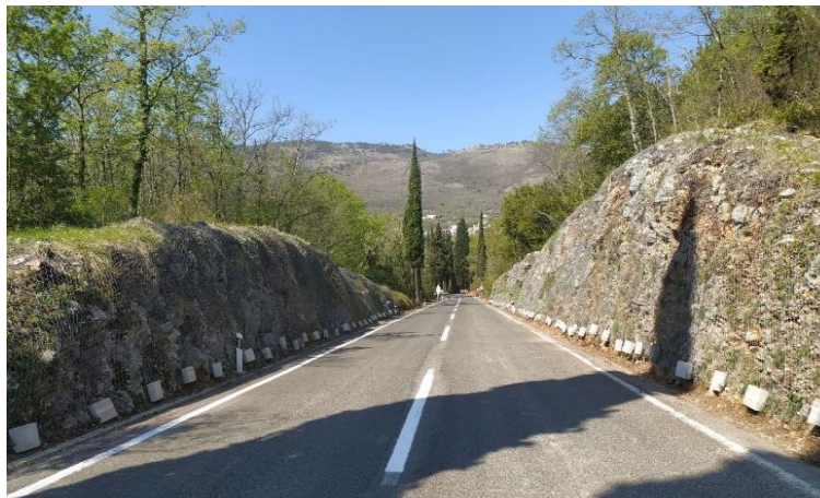
Slika 20. Prikaz izvedene zaštite postavljanjem zaštitne mreže
