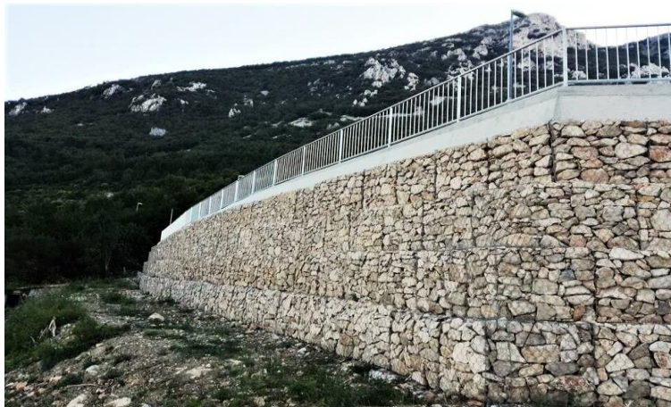
Slika 23. Gabionski zid
