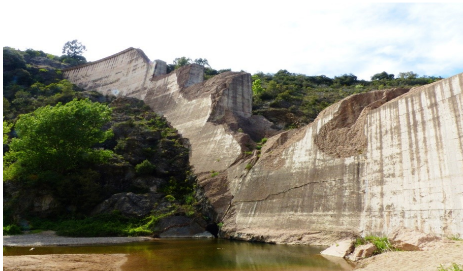
Slika 21. Izgled brane Maplasset nakon pucanja (preuzeto od: The ruins of the dam - Eolefr - Wikipedia, 2018., 27.8.2020.)
