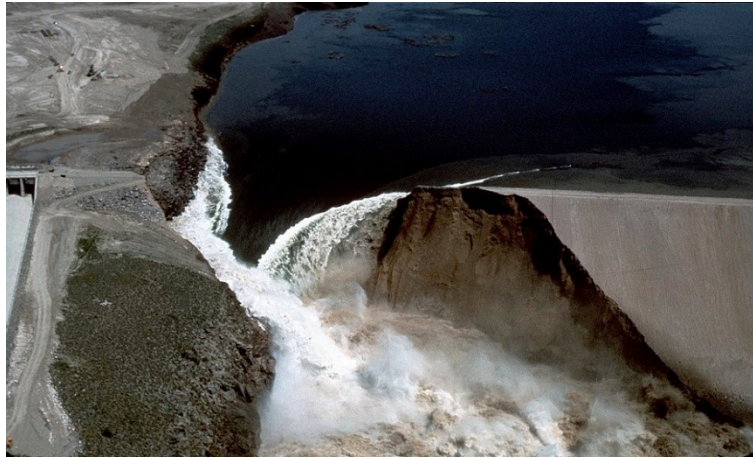
Slika 9. Poplava nakon urušavanja brane u istočnom Idahou 1976. godine (preuzeto sa: Teton Dam – Wikipedia, 27.8.2020.)
