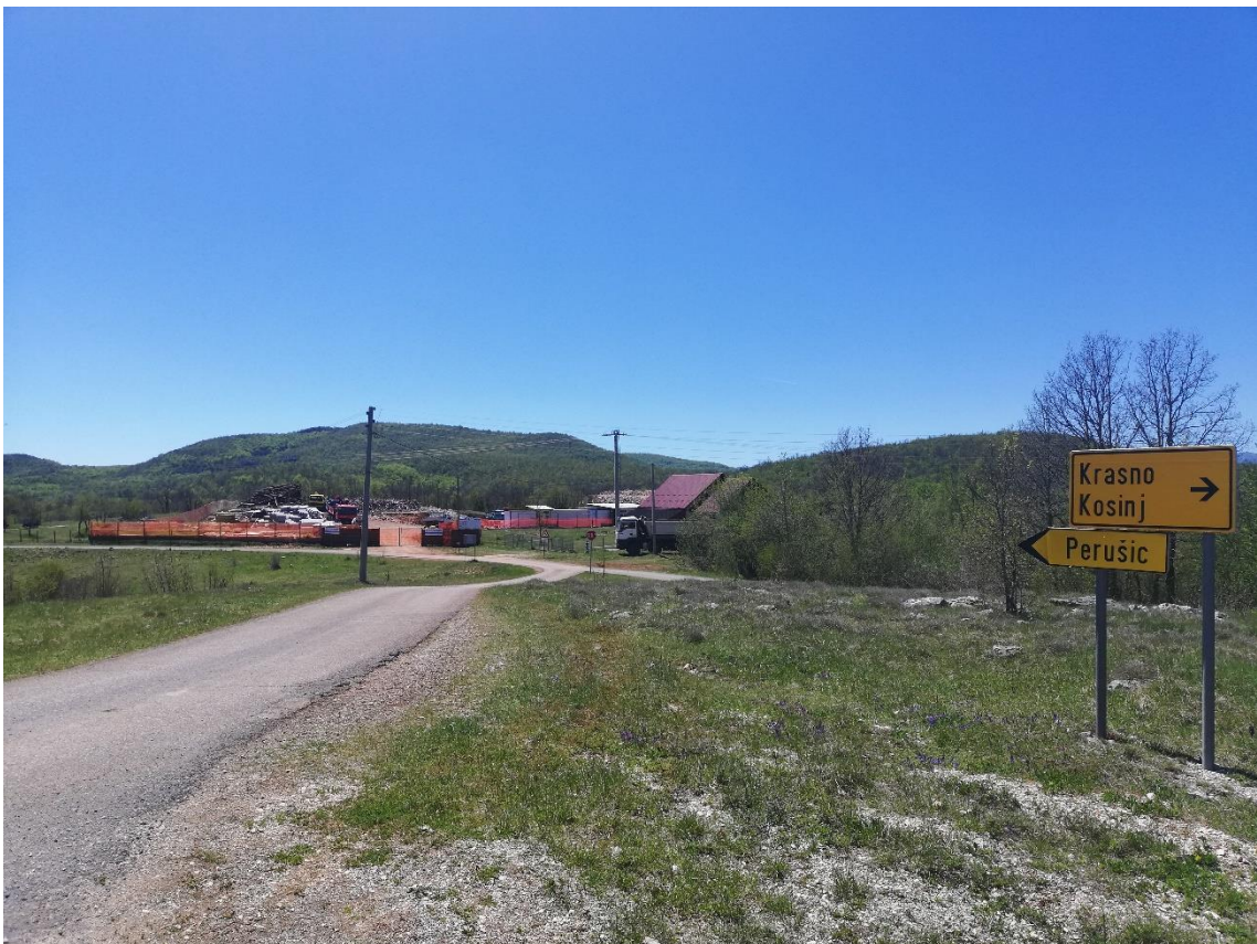
Slika 7. Izgradnja prometnice u naselju Studenci do HE Sklope
