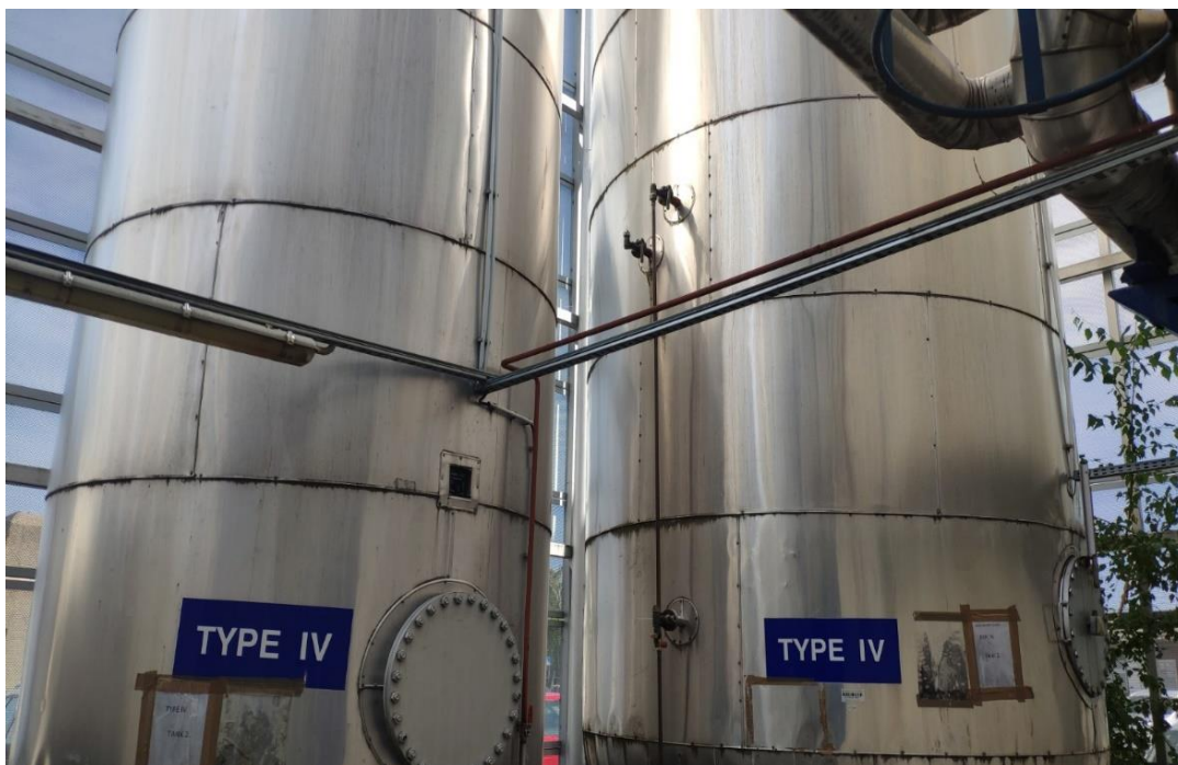
Slika 6: Spremnici za čuvanje tekućine za odleđivanje, tipa IV Izvor: Autor
