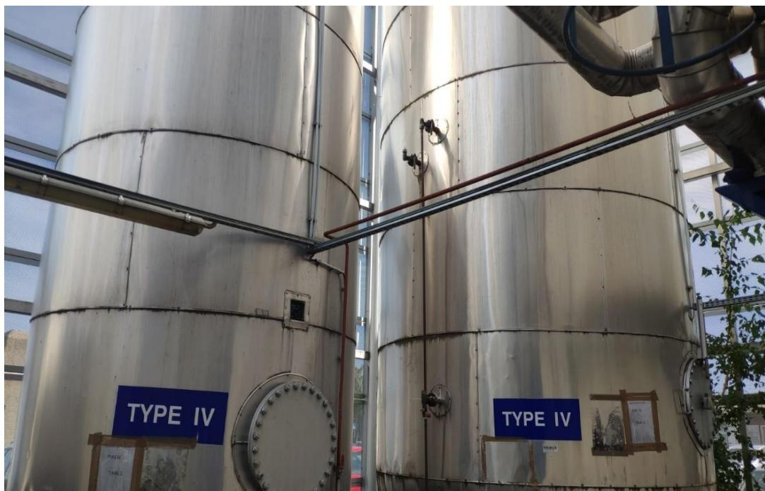
Slika 6: Spremniči za čuvanje tekućine za odleđivanje, tipa IV
