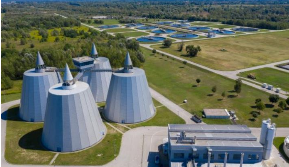
Slika 9. Digestori bioplinskog postrojenja u Zagrebu [17]
