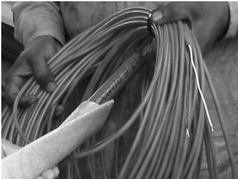
Slika 21. Ugradnja piezometra unutar PVD-a (Chu i Raju, 2003)
