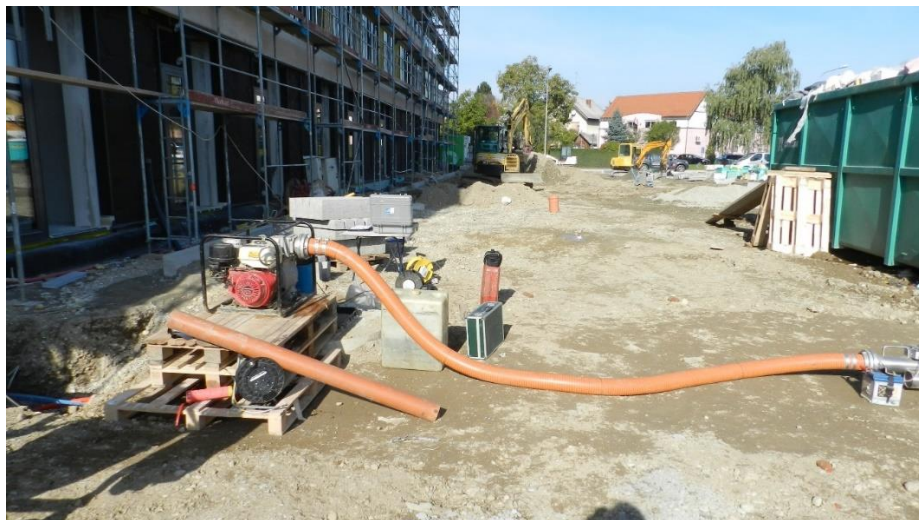
Slika 14. Primjer postavljanje crpke za pokusno crpljenje.
