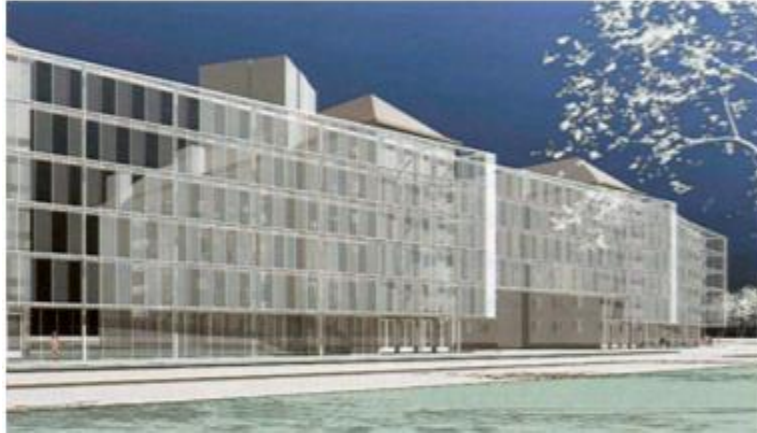
Slika 5. Prozirna barijera za zaštitu od buke i za prikupljanje sunčeve energije u Beču (SYLVIE, 2002.)
