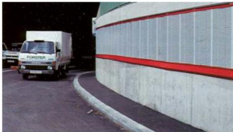
Slika 6. Obloženi zidovi podvožnjaka apsorbirajućim panelima (Noise protection, 2003.)
