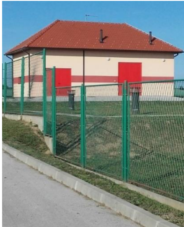
Slika 22. Precrpna stanica Kućan [2]
