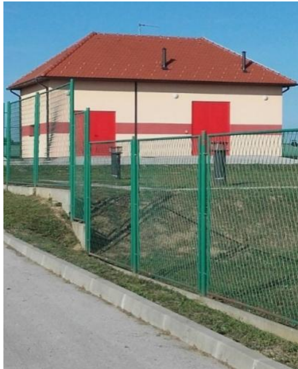
Slika 22. Precrpna stanica Kućan [2]
