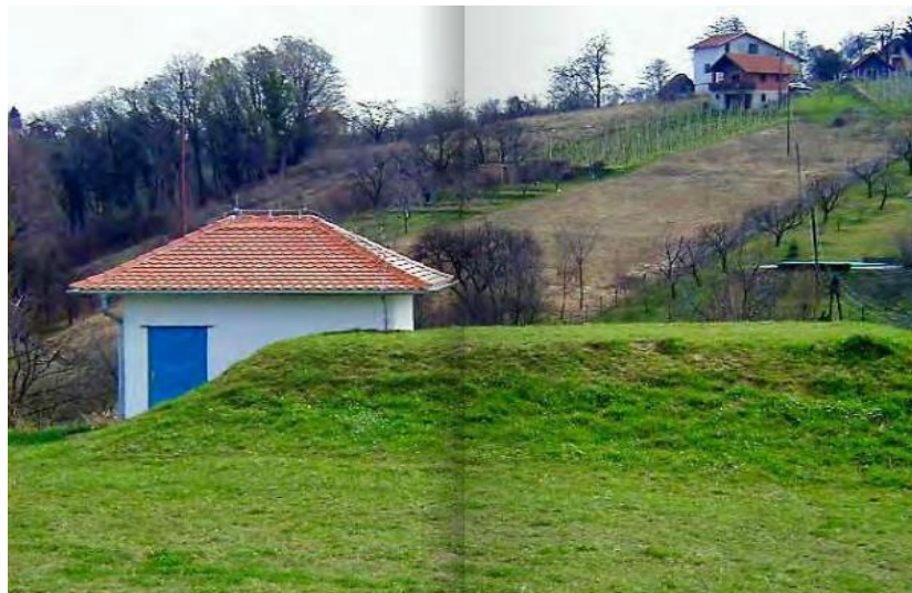
Slika 23. Vodosprema Tonimir volumena 500 m 3 [11]
