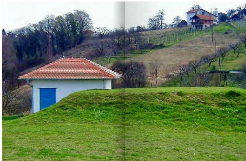
Slika 23. Vodosprema Tonimir volumena 500 m 3 [11]
