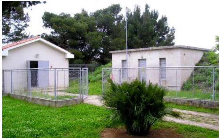
Slika 7. Vodosprema Kalvarija, otok Mali Lošinj [13]
