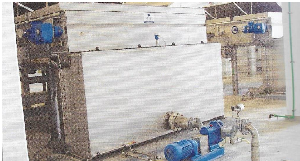
Slika 8. Dinamičko zgušnjavanje mulja na uređaju za pročišćavanje u Zagrebu [3]
