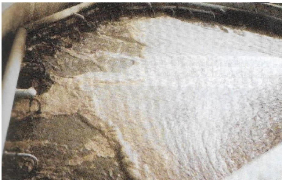
Slika 9. Aerobna stabilizacija mulja na uređaju za pročišćavanje u Varaždinu [3]
