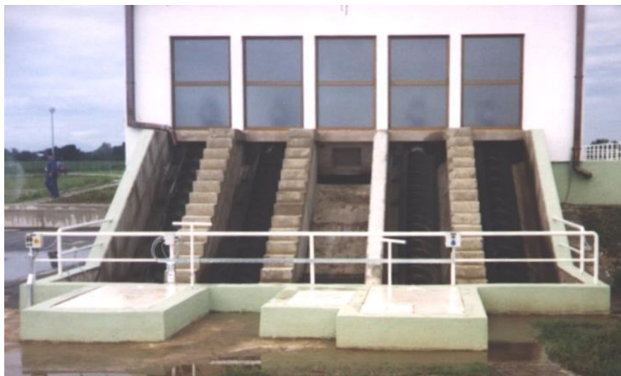
Slika 10. Crpilište biljnog mulja
