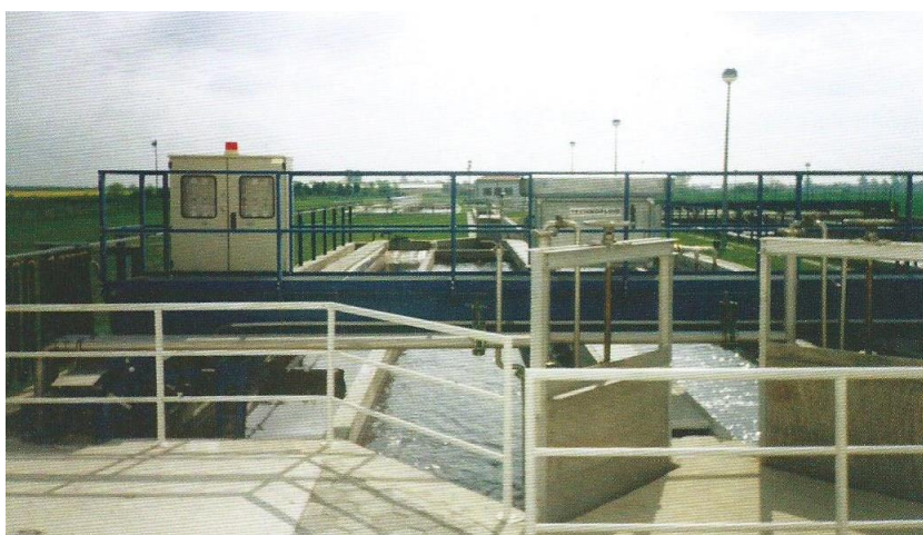
Slika 8. Prozračeni pjeskolov – mastolov na uređaju u Čakovcu
