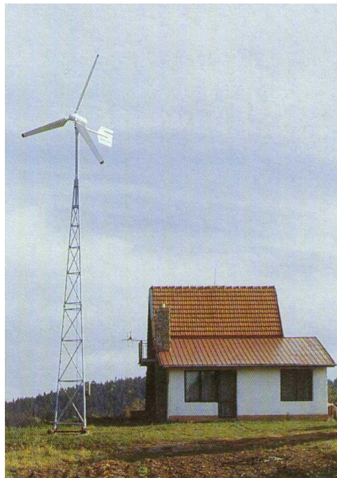
Slika 25. Upotreba malih vjetroturbina za opskrbu električnom energijom kuće [27].
