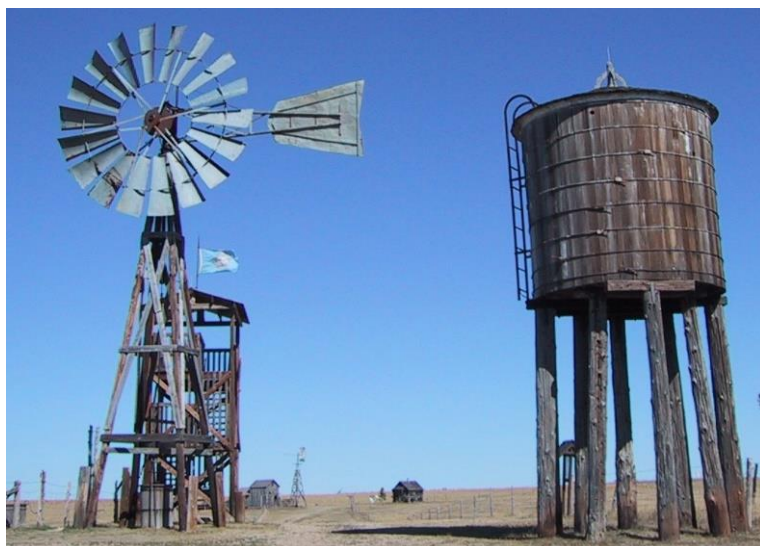
Slika 26. Upotreba malih vjetroturbina za crpljenje vode [28].
