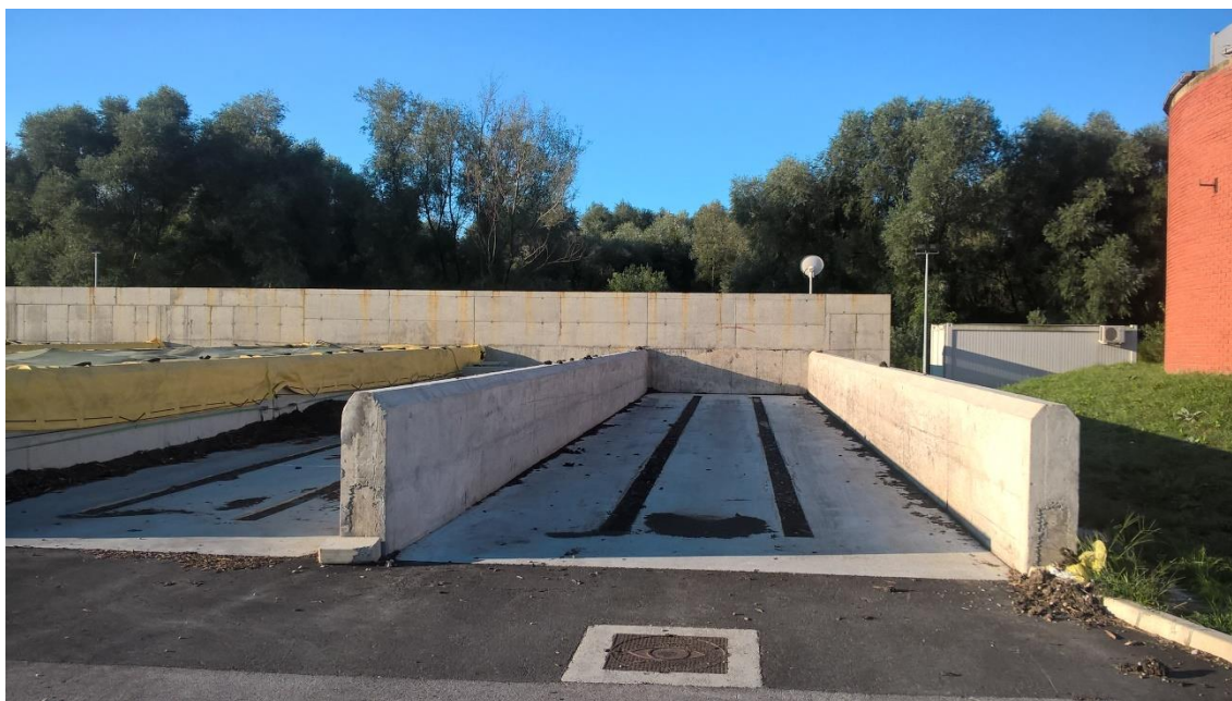
Slika 3.5 Prošireni kapaciteti kompostane sa sustavom upuhivanja zraka odozdo u polja – na slici crne trake
