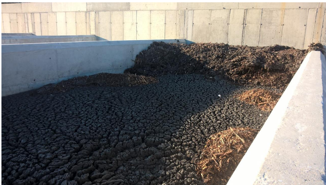
Slika 3.4 Mulj s UPOV-a pomiješan sa sječkom iz kojega se dobiva kompost treće kategorije za hortikulturu i gradske površine
