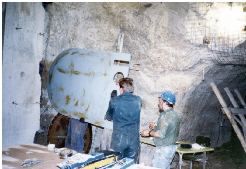
Slika 20. Ugradnja jastuka u vertikalni prorez (Godar-E-Landar, 1992)
