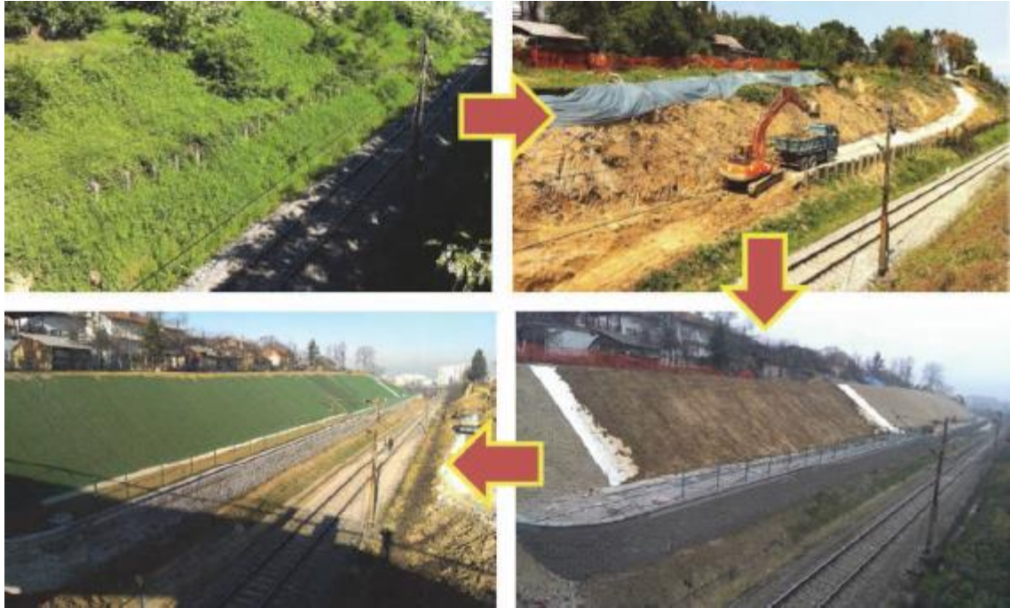
Slika 24. Izvedba sanacije klizišta na dionici A (Udović i sur. 2014)
