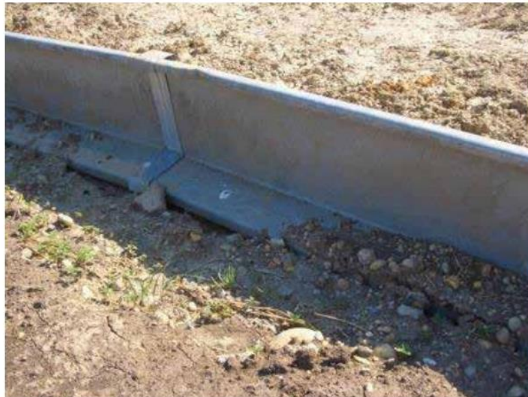
Slika 24. Metalna ograda za zaštitu vodozemaca od prometnica s vertikalnim i horizontalnim dijelovima (LACON, 2014).
