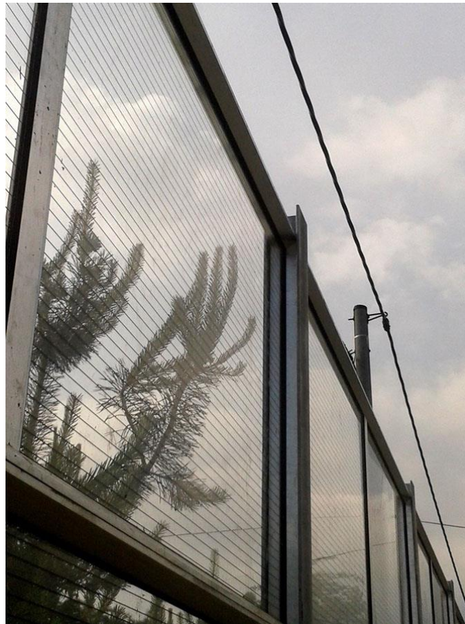
Slika 26. PLEXIGLAS® Soundstop sustav za smanjenje rizika od kolizije s pticama (Tomasz Chyra, CALVERO Sp. z o.o. Sp.k.).
